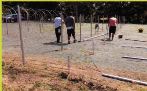
Fixation des poteaux.
