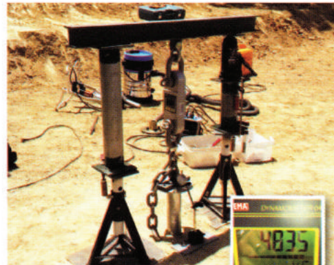
Test à l'arrachement.
