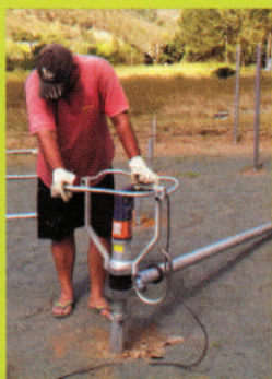
Installation des vis.
