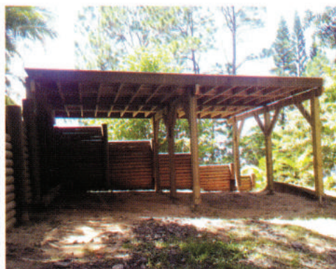
Fondations pour Carport.
