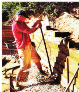
Renforcement de talus.
