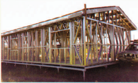
Villa structure métallique.
