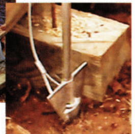
Ancre de 20,3 cm, installé avec marteau piqueur.
